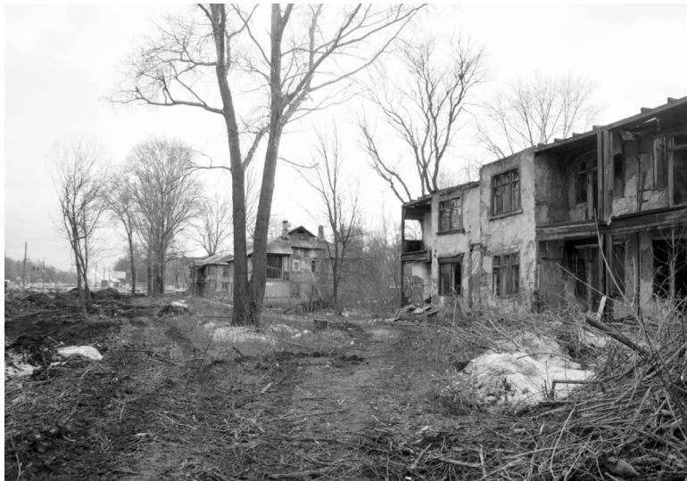
Рисунок 3. Пос. Мехзавод. Территория вдоль Московского шоссе
