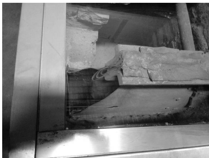
Рисунок 3 - Эллиптические металлические балки Зимнего дворца
